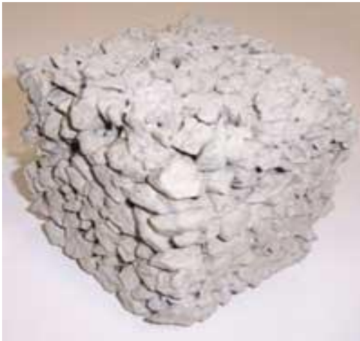
Ilustración 10 Mezcla de hormigón discontinua
