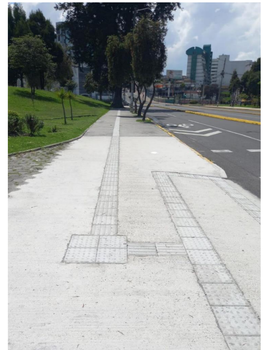
Nota: aceras con señalización podotáctil en Quito.
