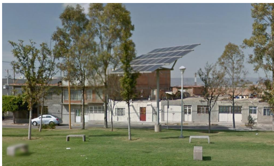
Foto 4: Paneles fotovoltaicos en Parque Línea Verde.
