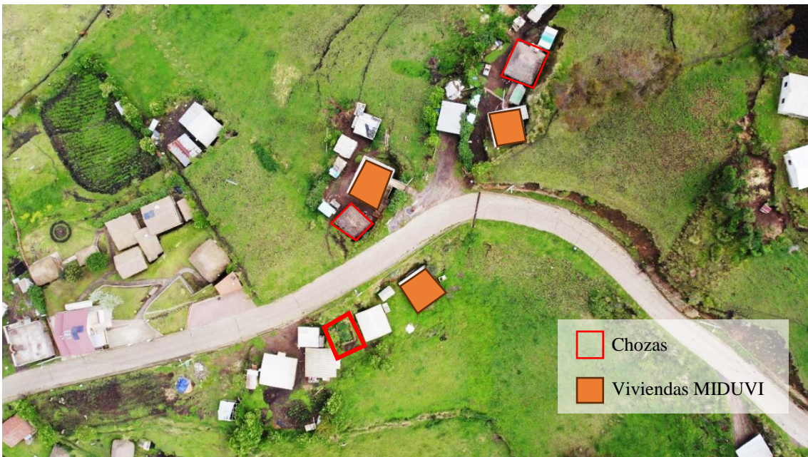
Imagen 38. Implantación viviendas de la comunidad La Esperanza, realizada por el autor
