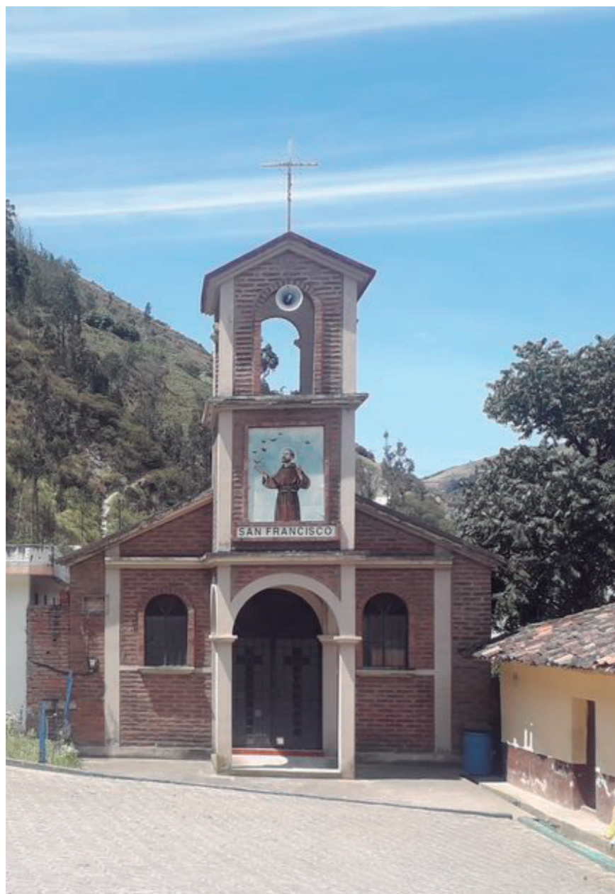
Figura 5. Sistema construido en la parroquia. Fuente: Elaboración propia, 2021.
