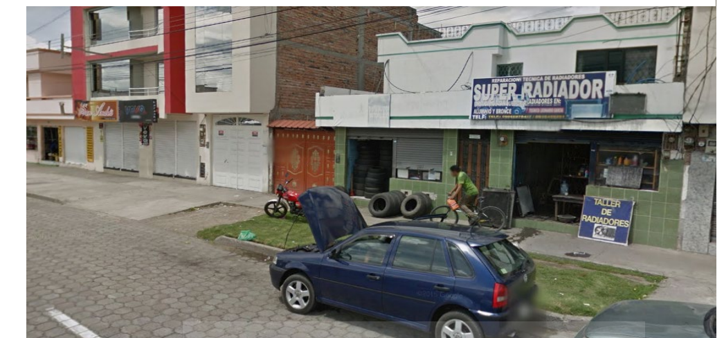
Figura 85 Inadecuado uso de aceras
