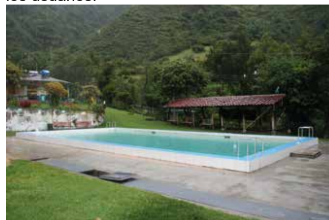
Figura 114: Piscina principal (rectangular) Fuente: Elaboración propia
