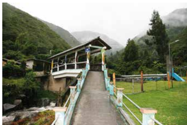
Figura 111: Puento sobre el río Huarmiyacu Fuente: Elaboración propia
