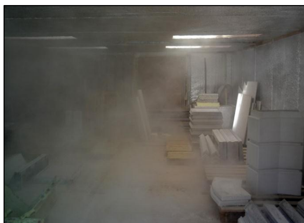
Figura 39. Curado de prefabricados en cuarto de vapor (GharPedia, 2019).
