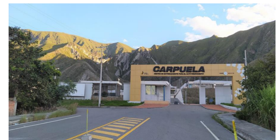
Figura 186: Fotografía centro de alto rendimiento comunidad Carpuela. Fuente: Daniel Fernando Benavides Guerra.
