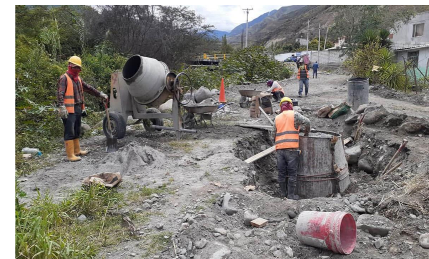
Figura 212: Fotografía ampliación del sistema de alcantarillado en la parroquia de Ambuquí. Fuente: El informante, publicado el 22 de febrero del 2021.
