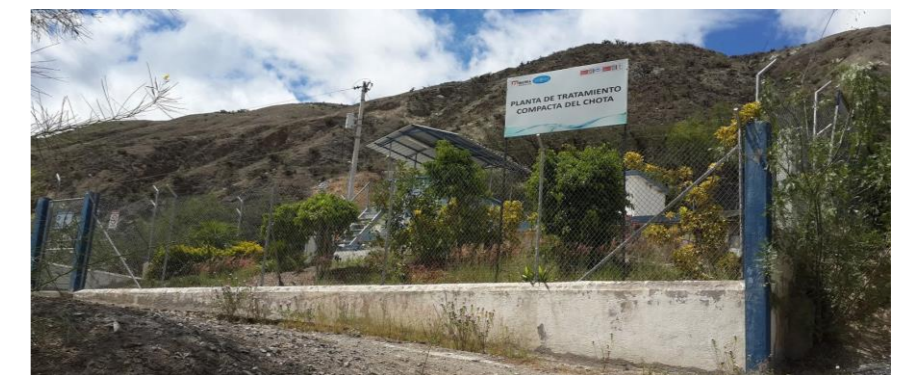
Figura 120: Fotografía planta de tratamiento compacta de agua comunidad El Chota. Fuente: Daniel Fernando Benavides Guerra.
