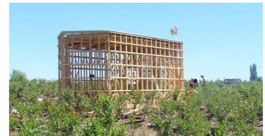
Figura 37: Fotografía panorámica de la estructura centro de acopio Quintasur. Fuente: Plataforma arquitectura.
