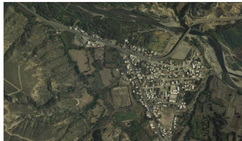
Figura 95: Fotografía aérea comunidad El Juncal. Fuente: GAD Ibarra.
