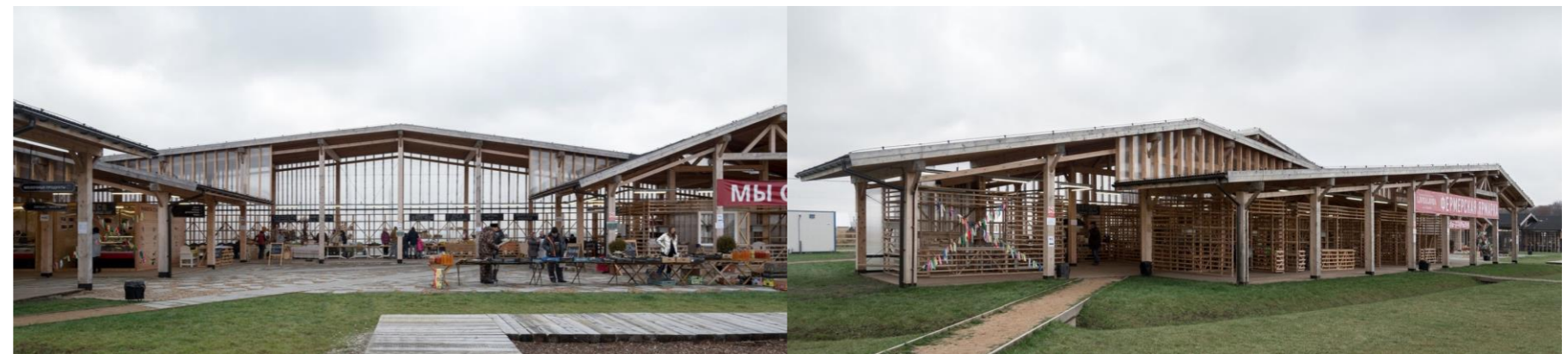
Figura 55: Fotografía panorámica mercado de agricultores. Fuente: Plataforma arquitectura.
