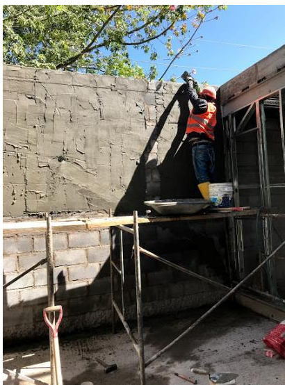
Ilustración 58: Colocación del mortero industrial
