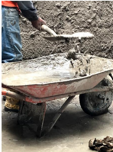
Ilustración 14: Colocación del mortero tradicional
