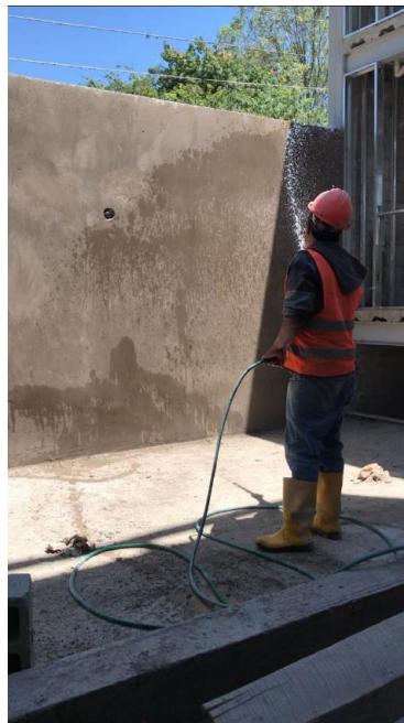
Ilustración 28: Análisis visual de la pared enlucida con mortero tradicional, primer día
