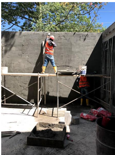
Ilustración 62: Nivelación de la pared enlucida con mortero industrial
