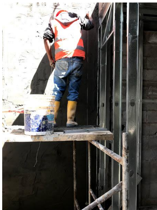
Ilustración 63: Nivelación de la pared enlucida con mortero industrial
