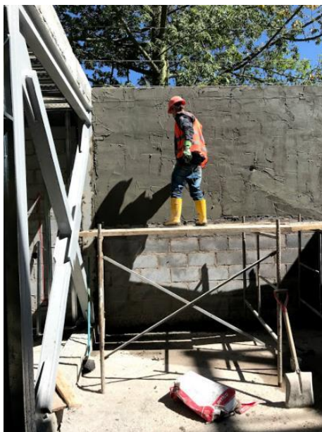
Ilustración 59: Colocación del mortero industrial
