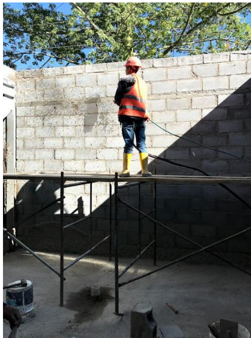
Ilustración 49: Preparación de la pared a ser enlucida
