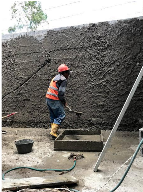
Ilustración 15: Colocación del mortero tradicional
