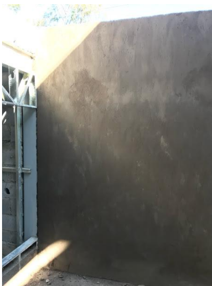
Ilustración 26: Análisis visual de la pared enlucida con mortero tradicional, primer día
