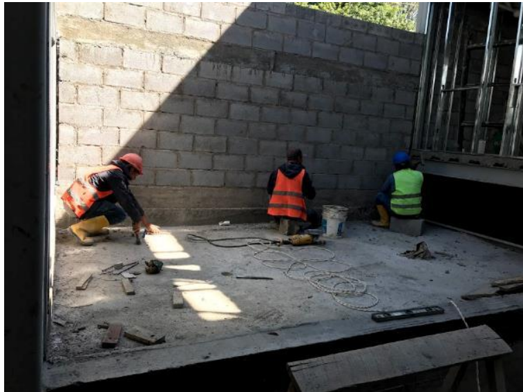
Ilustración 1: Nivelación pared
