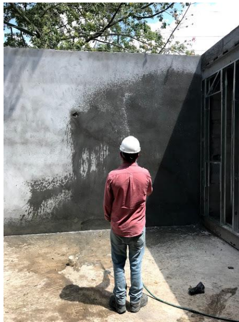
Ilustración 73: Análisis visual de la pared enlucida con mortero industrial, primer día
