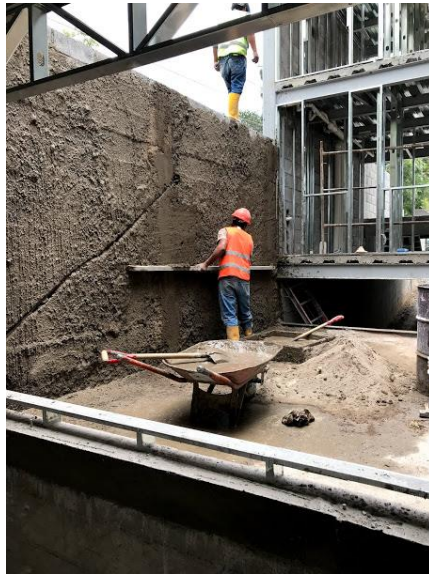
Ilustración 21: Colocación del mortero tradicional
