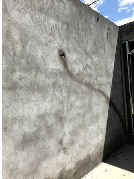
Ilustración 72: Análisis visual de la pared enlucida con mortero industrial, primer día
