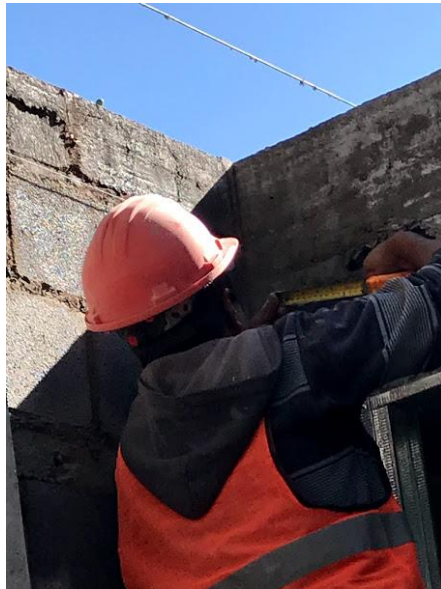
Ilustración 54: Espesor requerido para enlucir con el mortero industrial
