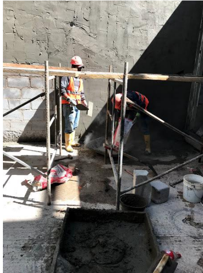
Ilustración 60: Colocación del mortero industrial
