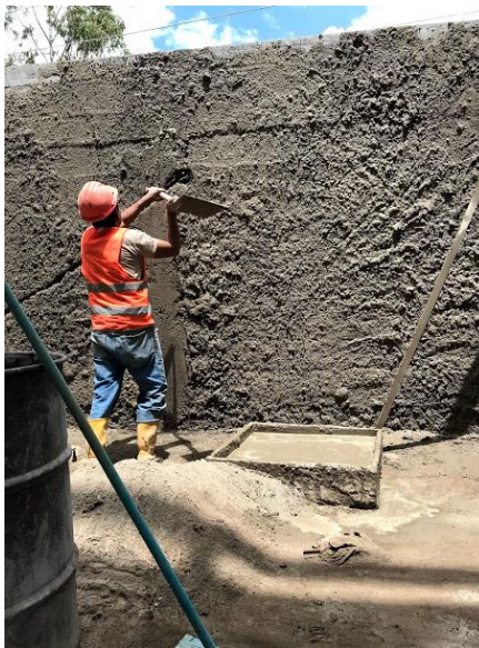
Ilustración 20: Colocación del mortero tradicional
