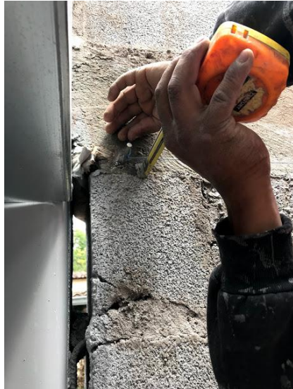
Ilustración 8: Espesor del mortero tradicional a colocar
