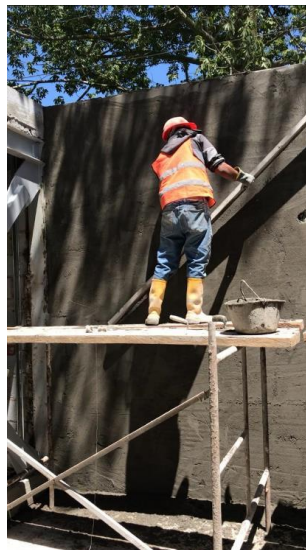
Ilustración 61: Nivelación de la pared enlucida con mortero industrial
