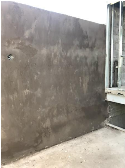
Ilustración 27: Análisis visual de la pared enlucida con mortero tradicional, primer día
