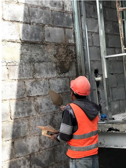
Ilustración 12: Colocación del mortero tradicional
