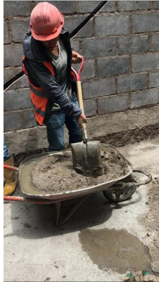
Ilustración 10: Dosificación del mortero tradicional
