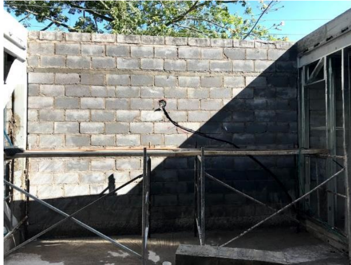
Ilustración 50: Preparación de la pared a ser enlucida
