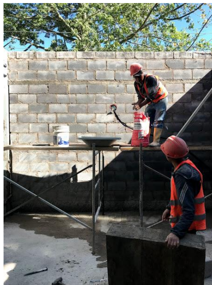
Ilustración 51: Dosificación del mortero industrial
