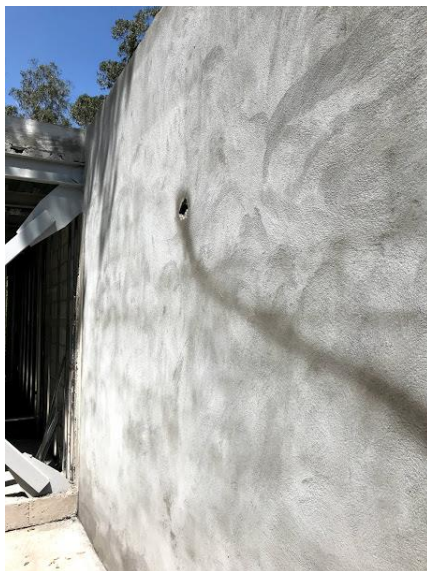
Ilustración 71: Análisis visual de la pared enlucida con mortero industrial, primer día
