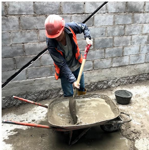
Ilustración 11: Dosificación del mortero tradicional
