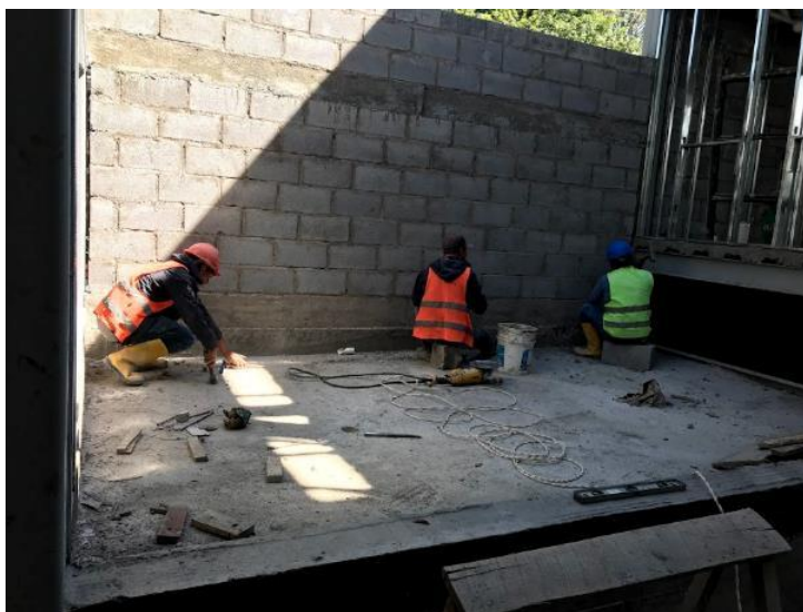
Ilustración 47: Nivelación de la pared a enlucir con mortero industrial
