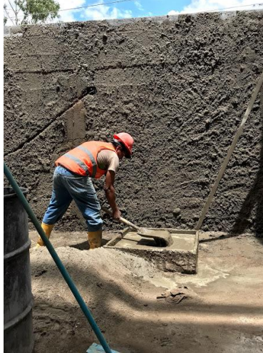
Ilustración 19: Colocación del mortero tradicional
