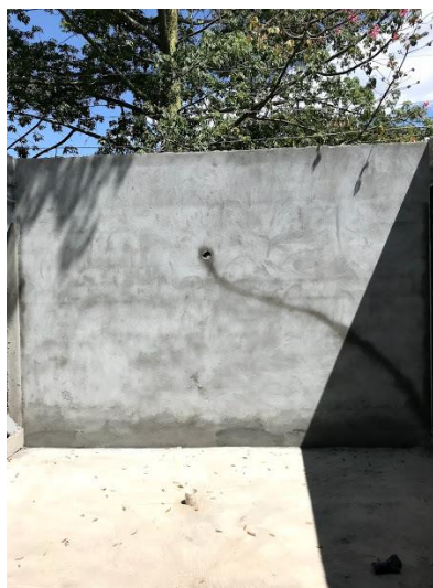
Ilustración 69: Análisis visual de la pared enlucida con mortero industrial, primer día
