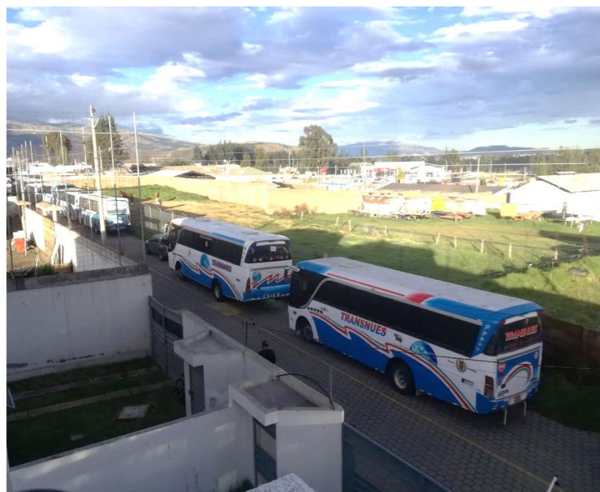
Figura 4: Situación actual del terminal terrestre de Cayambe Fuente: Elaboración propia
