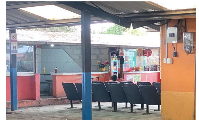
Figura 7: Situación actual del terminal terrestre de Cayambe Fuente: Elaboración propia
