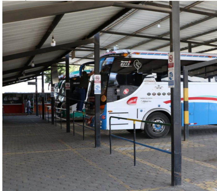
Figura 3: Situación actual del terminal terrestre de Cayambe Fuente: Elaboración propia
