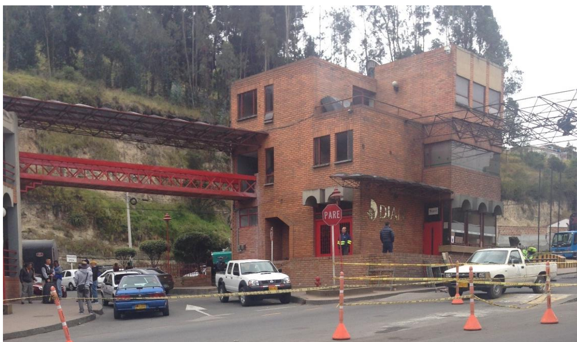
Figura 10. Edificación existente aduana Colombia
