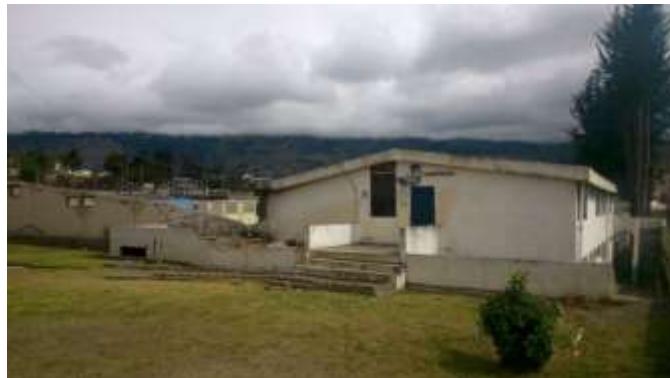
Fotografía 18: Sistema estructural, viga y columna de hormigón.
