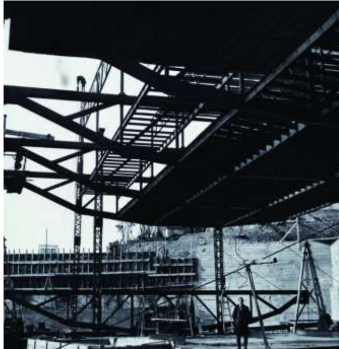
Imagen 18: Proceso de construcción en la zona de gimnasio.
