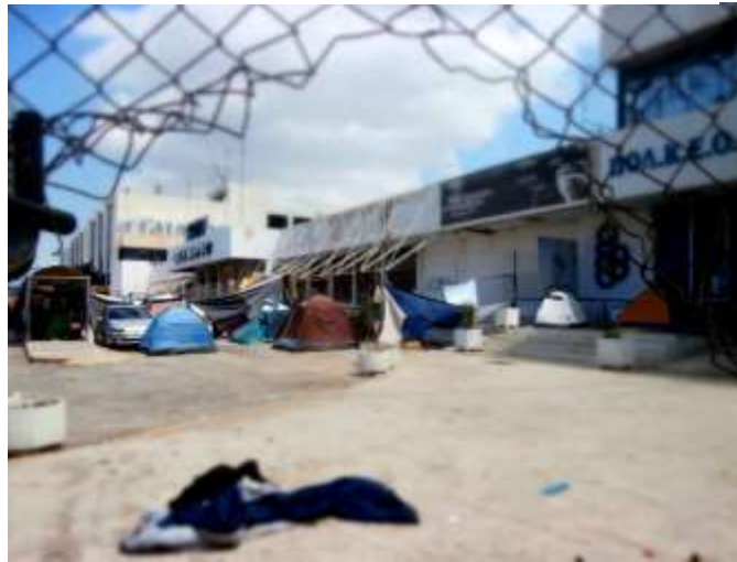
Imagen 9: Estado actual del ex aeropuerto.
