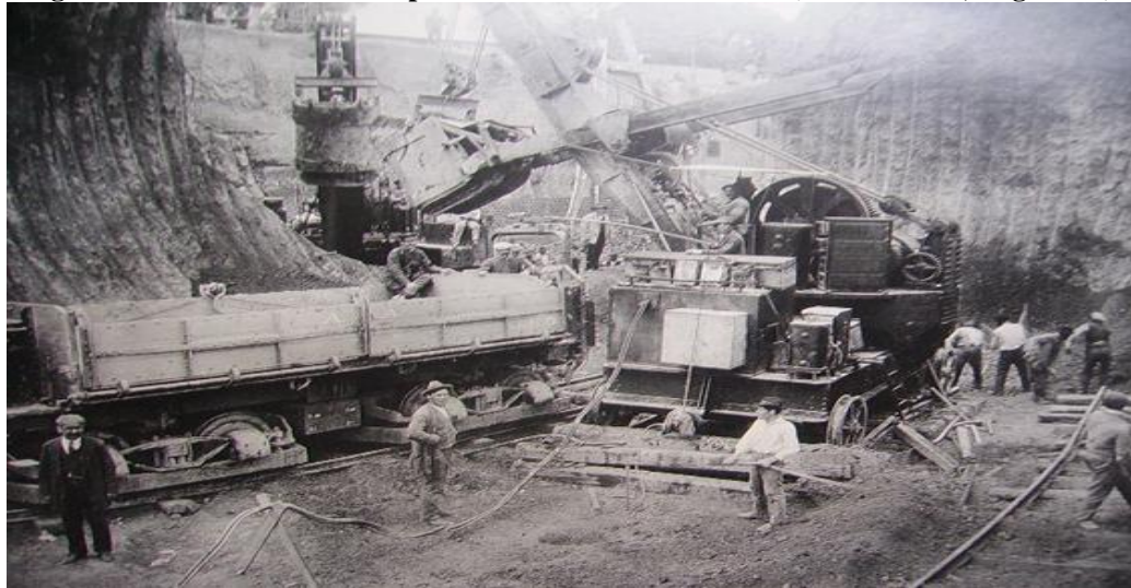
Figura 2. 5 Construcción de la primera línea de subterráneos (Buenos Aires, Argentina)
