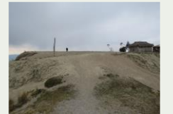
Plaza central deteriorada
