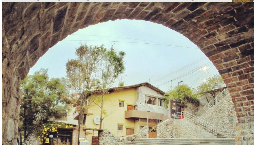
Figura 65: Interior arcos, Puente Roto, Cuenca.
