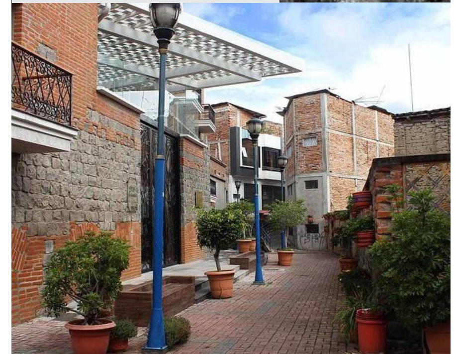
Figura 34: Rehabilitación urbana, corazones de manzana, Otavalo - Imbabura.
