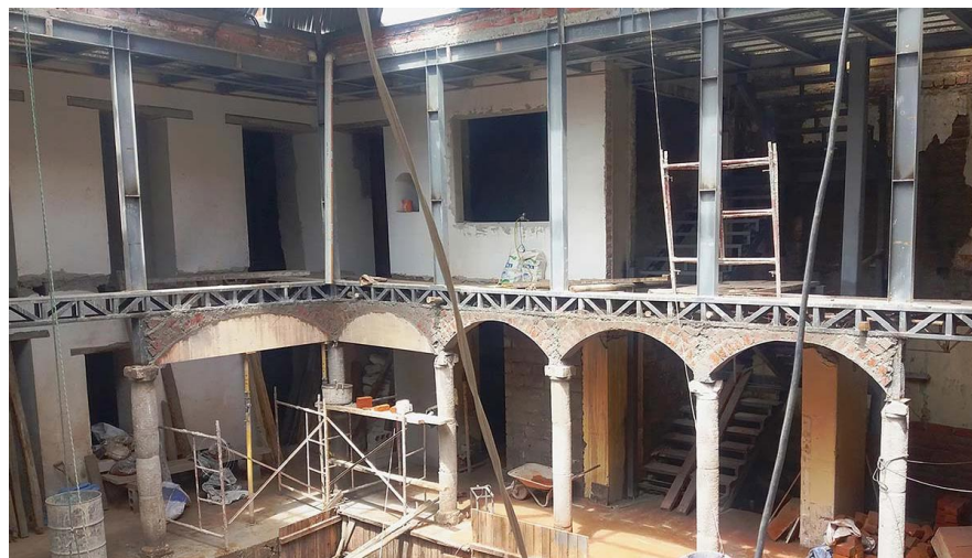
Figura 59: Espacio interior proceso de Rehabilitación, Casa Alvimia.
