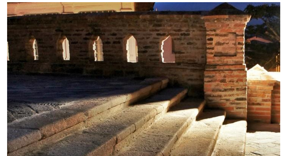
Figura 63: Rehabilitación gradas - Puente Roto, Cuenca.
