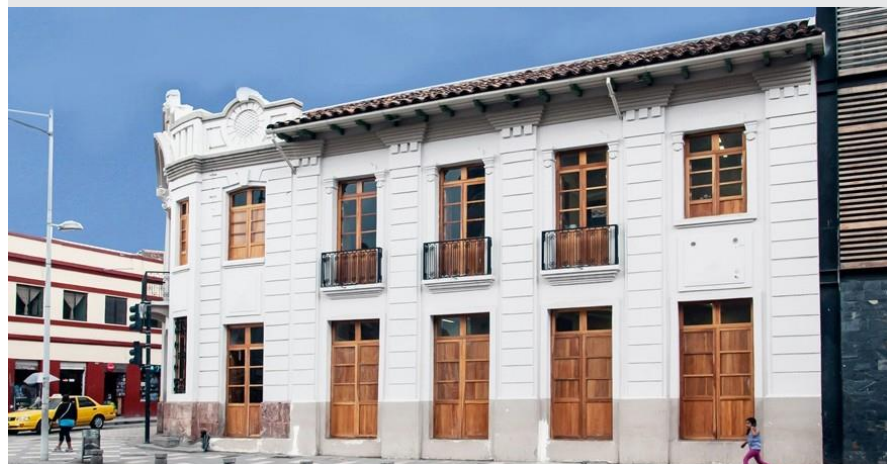
Figura 69: Fachada rehabilitada, Casa Neira.
