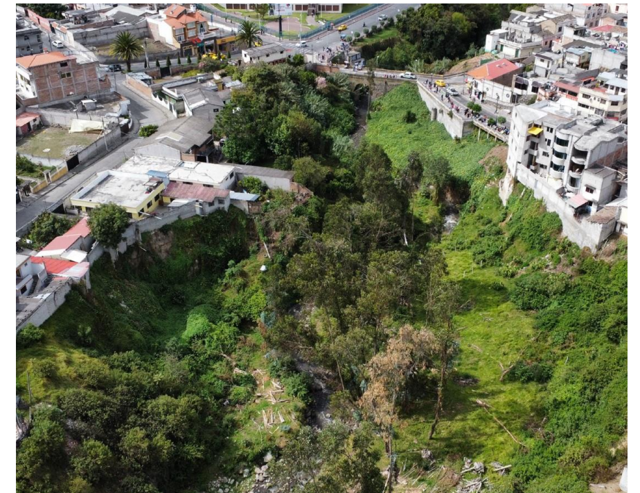
Figura 15: Quebrada La Banda, Otavalo. Fuente: Elaboración propia, 2022.
