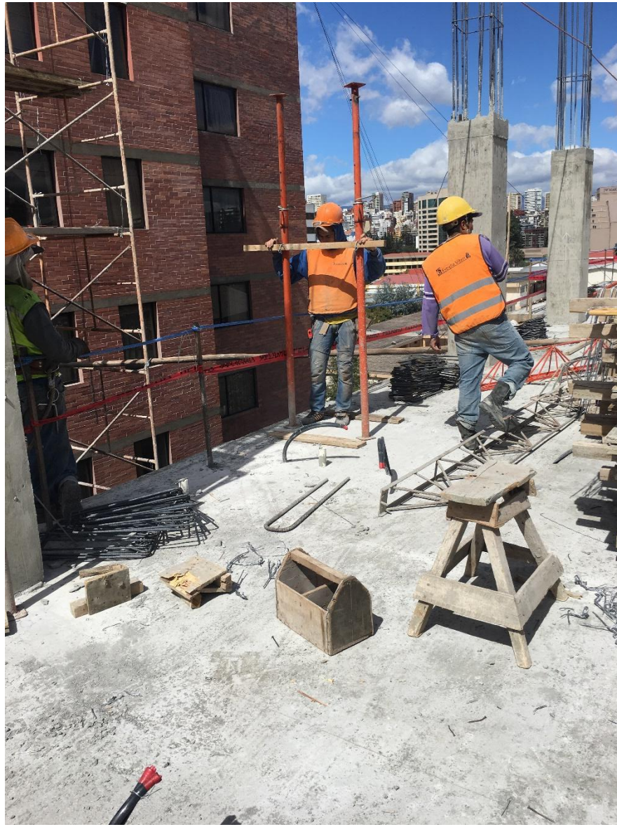
Fotos 24. Obrero colocando el puntal para el encofrado de la viga (YACARLA)
