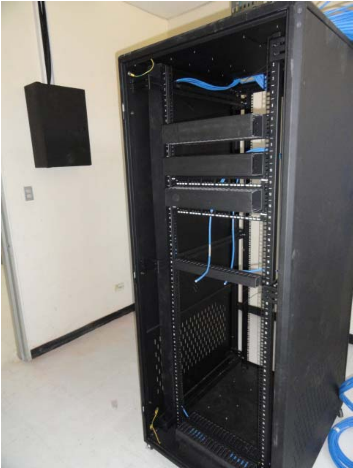
Ilustración 85 - Rack central con ordenadores horizontales
