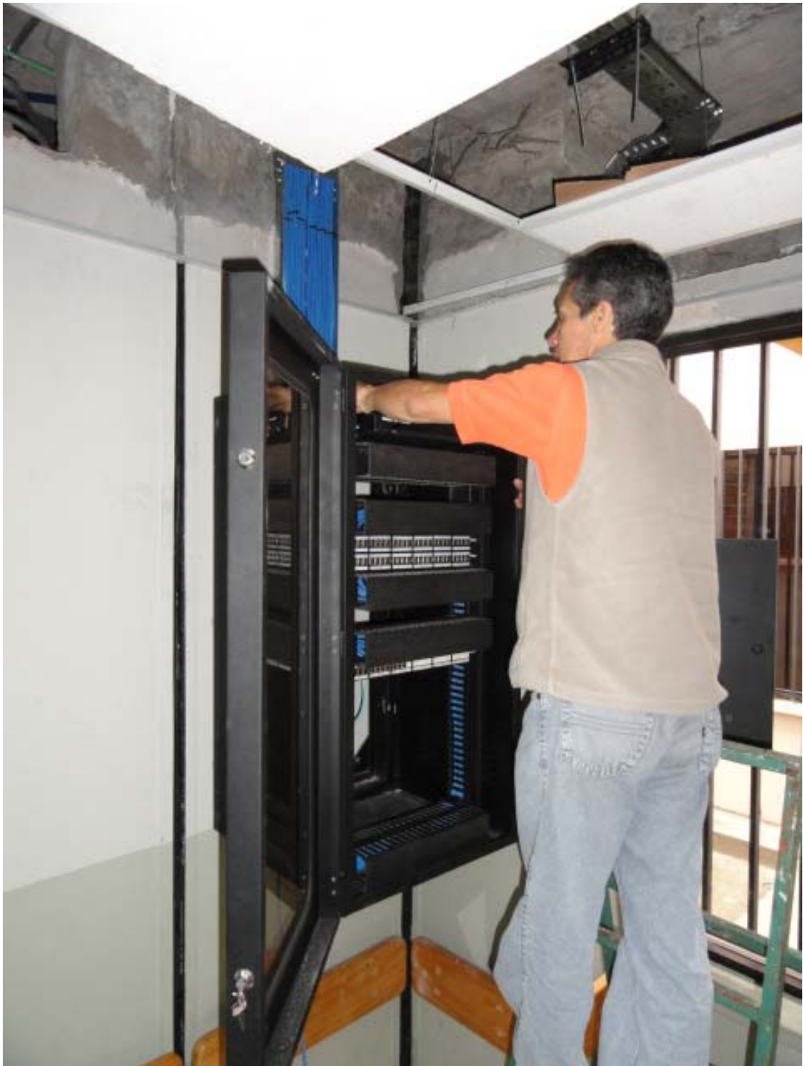
Ilustración 77 - Construcción de un gabinete abatible de pared
