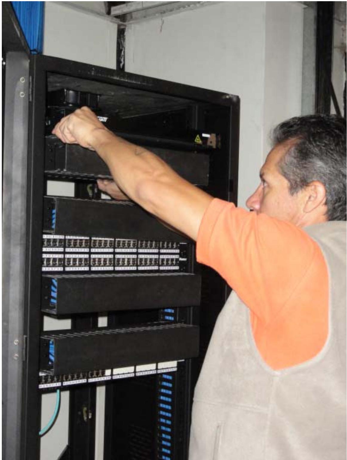
Ilustración 80 - Instalación de los componentes del rack
