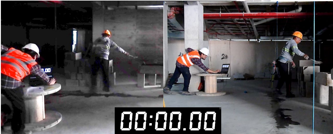
Figura 19. Inicio del ensayo - método tradicional de mampostería. (Imagen propia)
