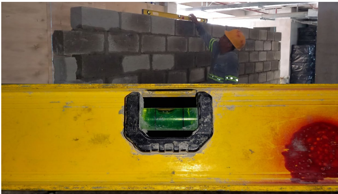
Figura 26. Nivel horizontal, segunda jornada- método tradicional (Imagen propia)
