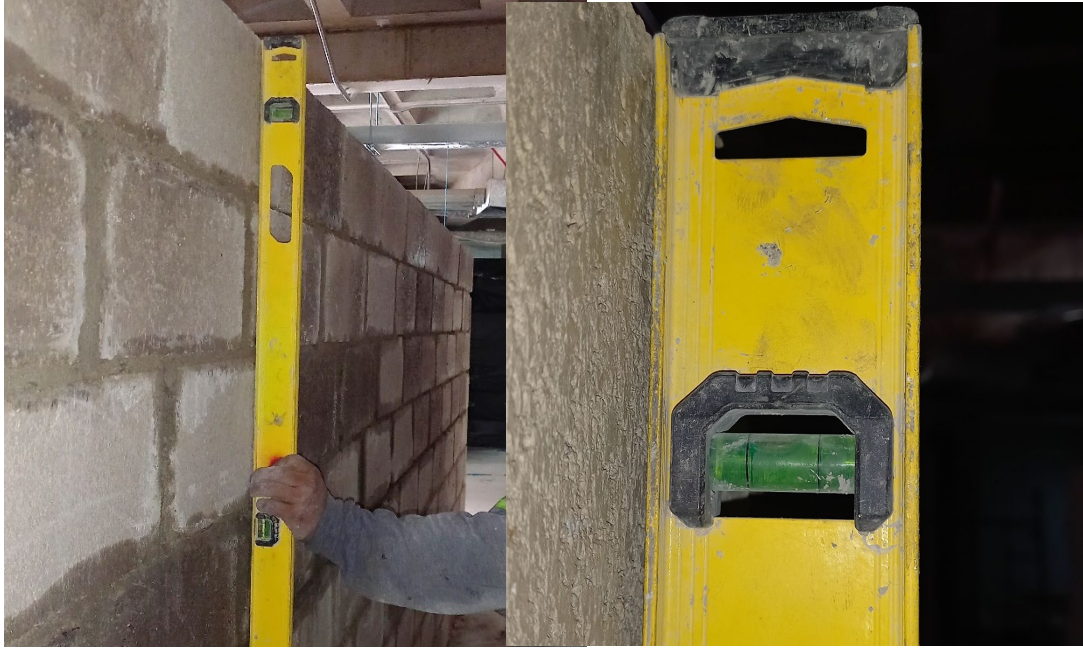
Figura 27. Nivel vertical, segunda jornada- método tradicional (Imagen propia)
