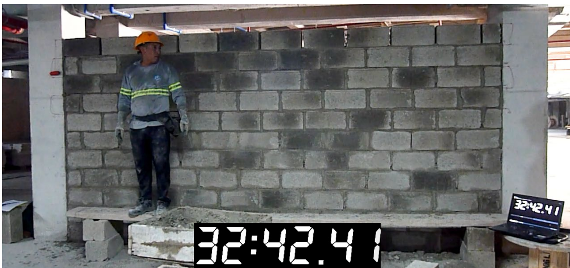
Figura 23. Primera jornada- método hiladas en paralelo: 53 minutos y 29 segundos. (Imagen propia)
