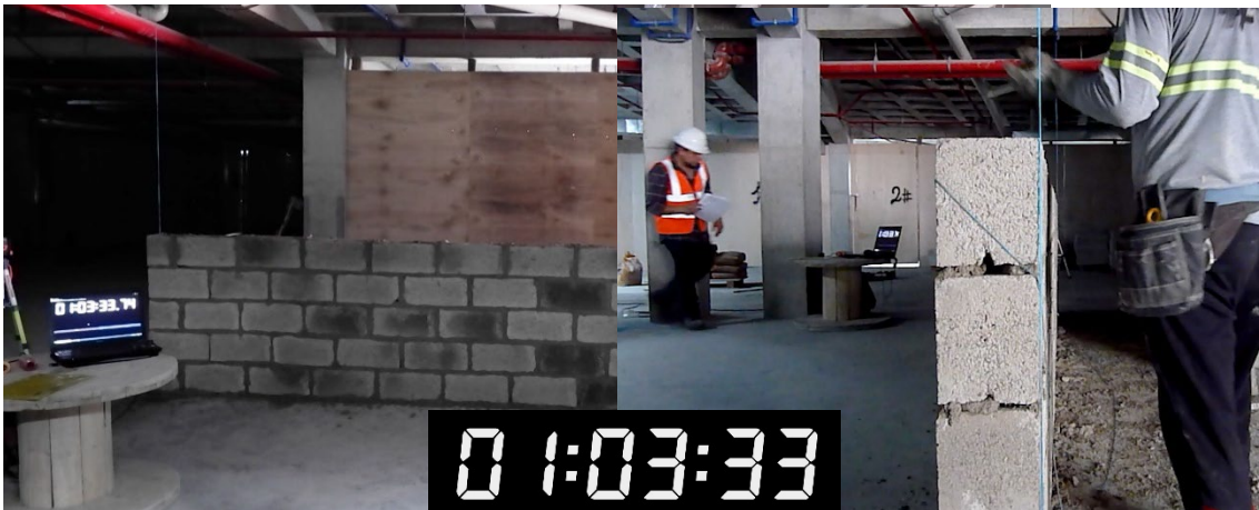
Figura 20. Primera jornada- método tradicional: 1 hora, 03 minutos y 33 segundos. (Imagen propia)
