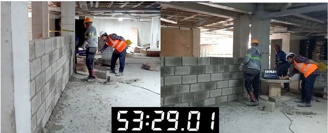
Figura 23. Primera jornada- método hiladas en paralelo: 53 minutos y 29 segundos. (Imagen propia)
