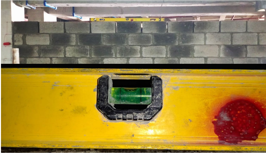
Figura 29. Nivel horizontal, segunda jornada- método hiladas en paralelo (Imagen propia)
