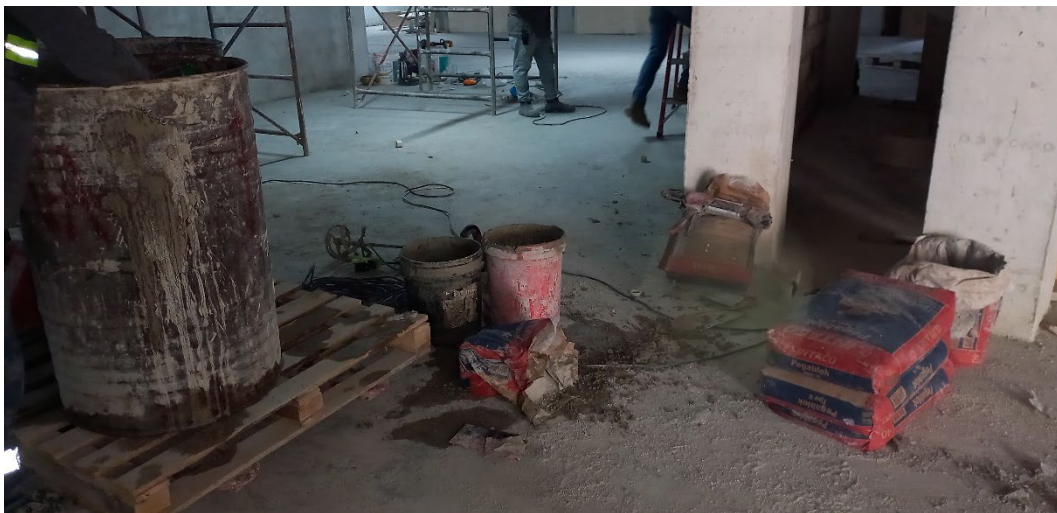
Figura 39. Mezcla de sacos de pegablock tipo N de 40 kg, utilizados en los ensayos (Imagen propia)
