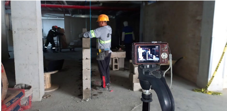
Figura 18. Cámara lateral capturando el proceso de mampostería desde el costado. (Imagen propia)
