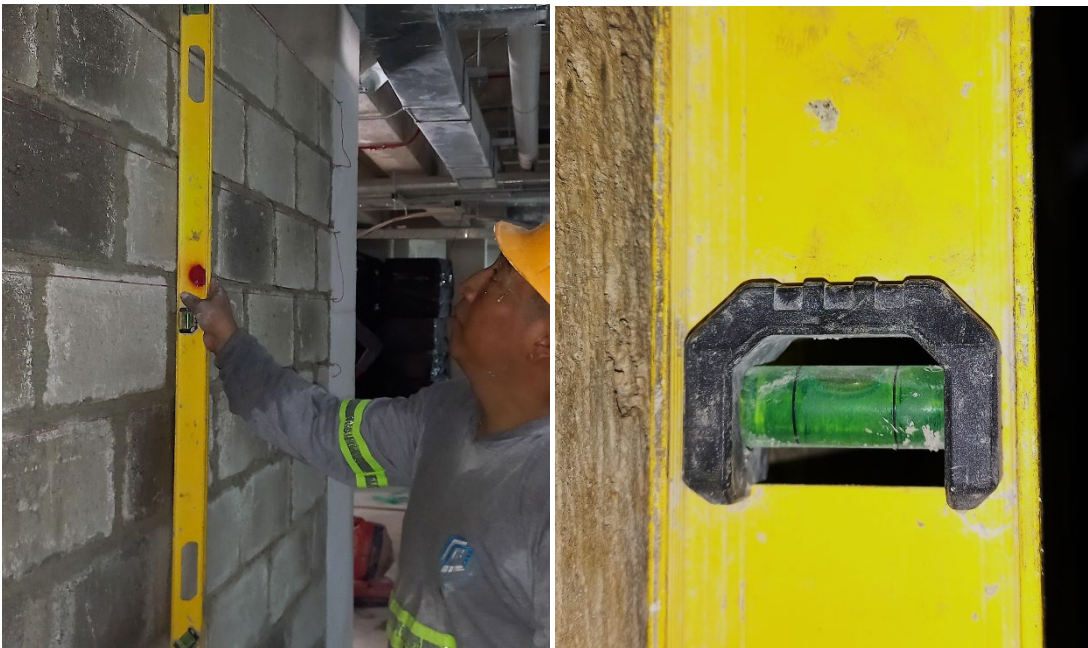
Figura 30. Nivel vertical, segunda jornada- método hiladas en paralelo (Imagen propia)
