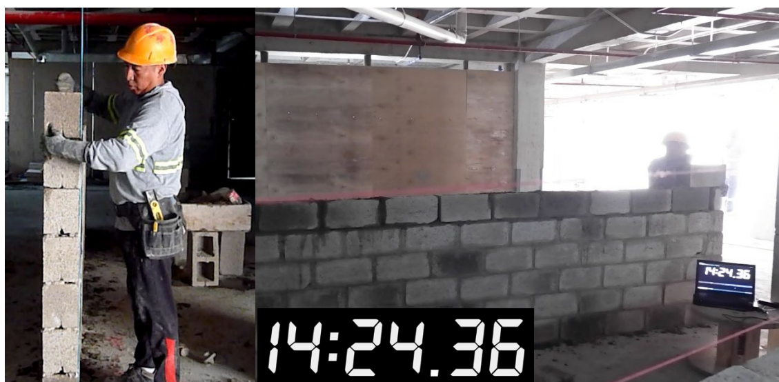
Figura 33. Reajuste de bloque, método tradicional: 14 minutos y 24 segundos. (Imagen propia)
