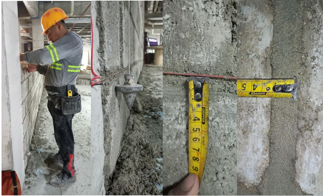
Figura 28. Control geométrico, primera jornada- método hiladas paralelo (Imagen propia)
