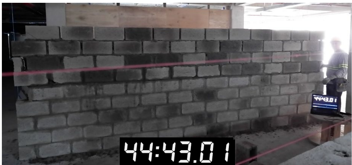
Figura 21. Segunda jornada- método tradicional: 44 minutos y 43 segundos. (Imagen propia)
