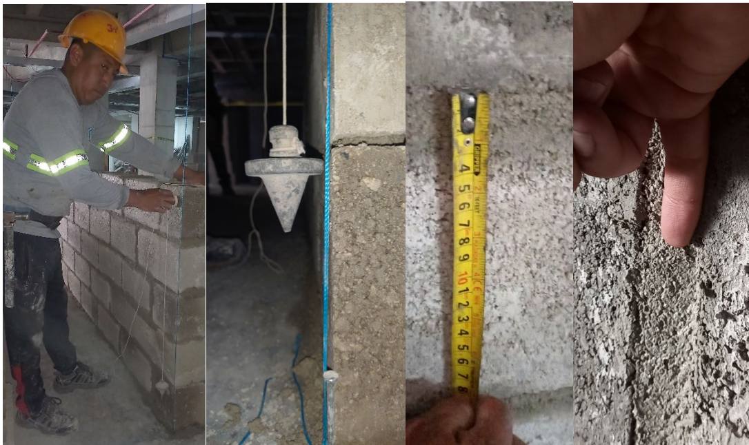
Figura 25. Control geométrico, primera jornada- método tradicional (Imagen propia)
