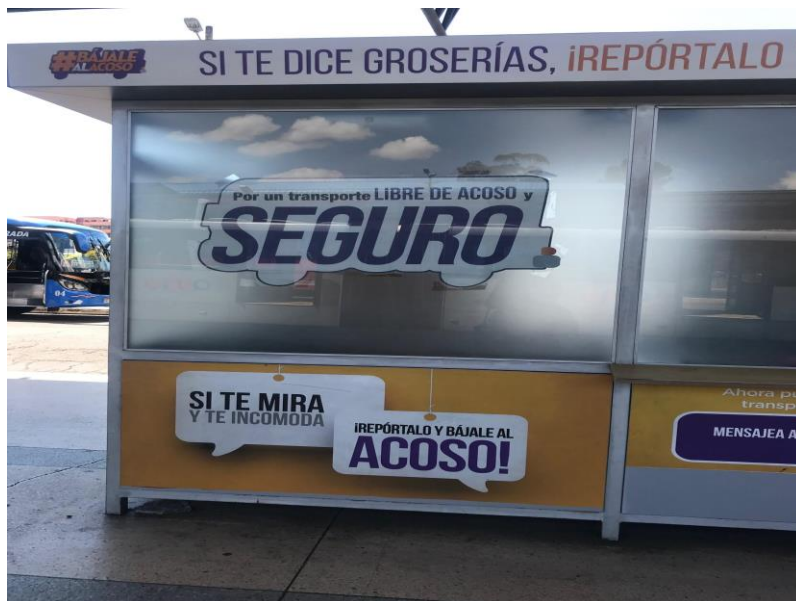
Fotografía estación Río Coca
