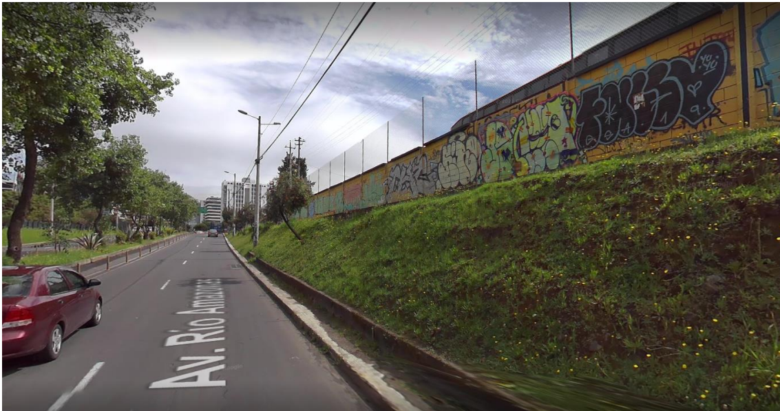
Ilustración 6 Av. Río Amazonas junto con colegio militar Fuente: (GOOGLE, 2022)
