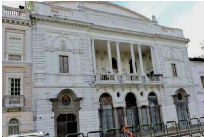
Figura 3.3. Fachada teatro Capitol (Teatro Capitol, n.d.)
