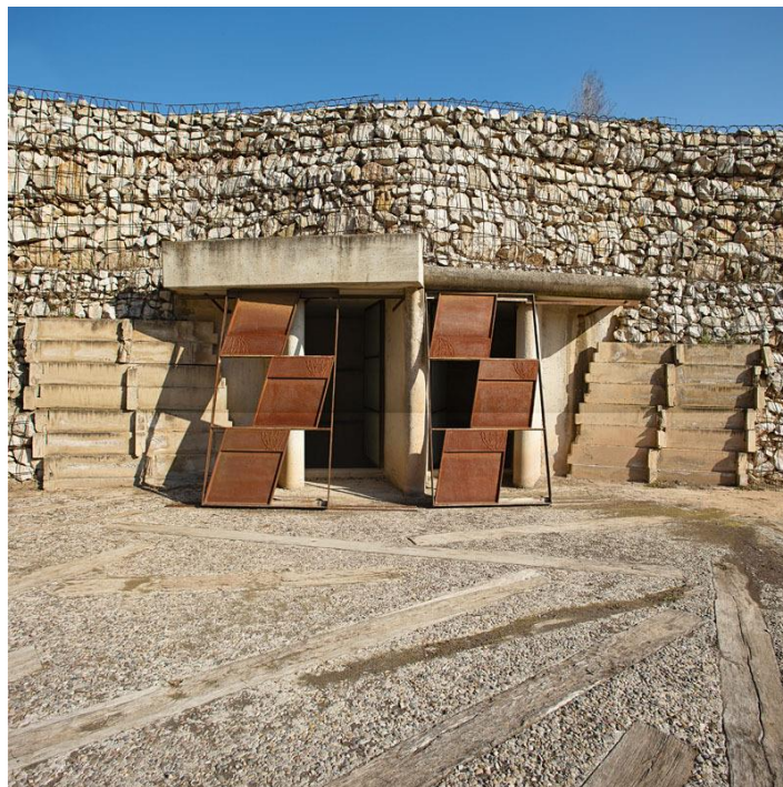
Imagen 7: Detalle de muros y accesos
