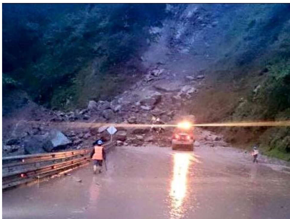
8 Foto: Trabajo de despeje en el kilómetro 28+400 las 24 horas
