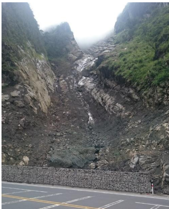
3 Foto: Movimiento en masa en el kilómetro 28
