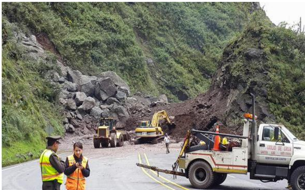
7 Foto: Despeje de vía en el km 28+400
