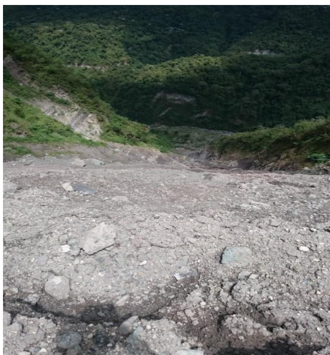
4 Foto: Movimiento en masa del kilómetro 28 caídas de rocas al río al otro lado de la vía.
