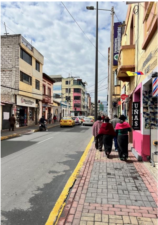
Tipo de postes (hormigón). 28-11-2022
