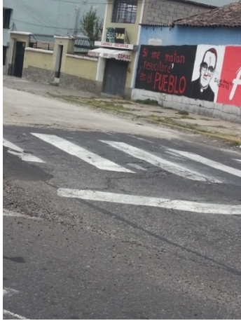
Foto No. 2.12. Calle M. Varela, Quito
