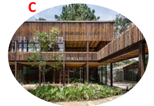
Centro cultural Plaza Andaro Avandaro, México
