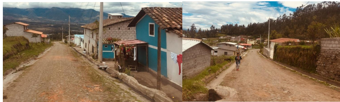
Figura N° 60: Calle la esperanza, altura de edificaciones Fuente: Fotografías propias 2020
