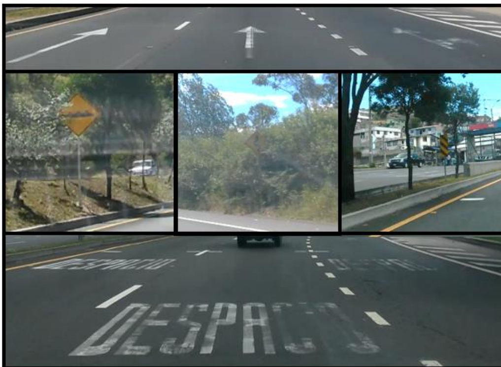
Foto 4-4 Ejemplos de señalización con un estado de conservación “medio” en la Av. Simón Bolívar
