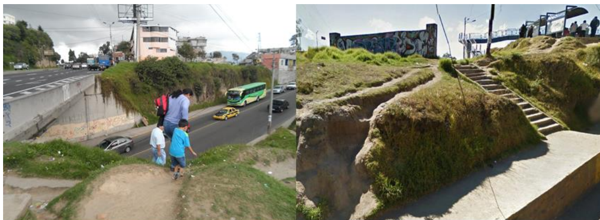
Foto 6-1 Condiciones peatonales sector Juan Bautista Aguirre
