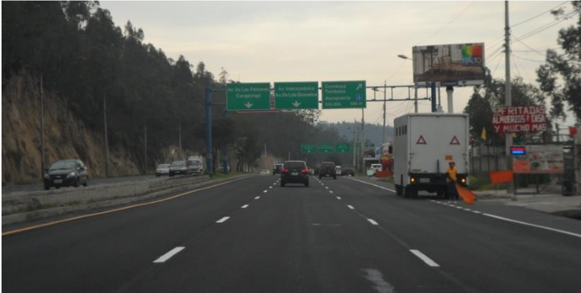
Foto 1-5 Condiciones Topográficas sector ingreso a Ruta Viva sentido S-N
