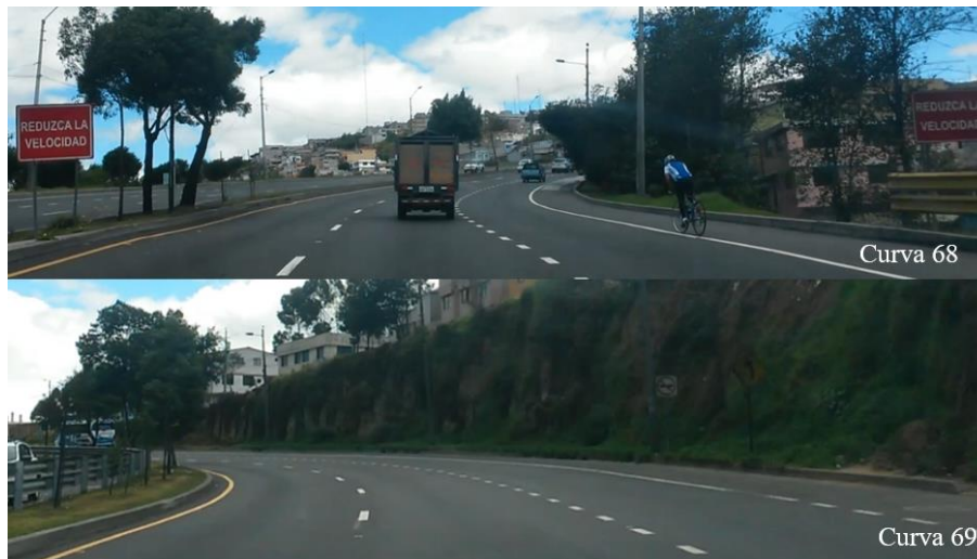
Foto 4-9 Señalización vertical curvas 68 y 69 sentido N-S
