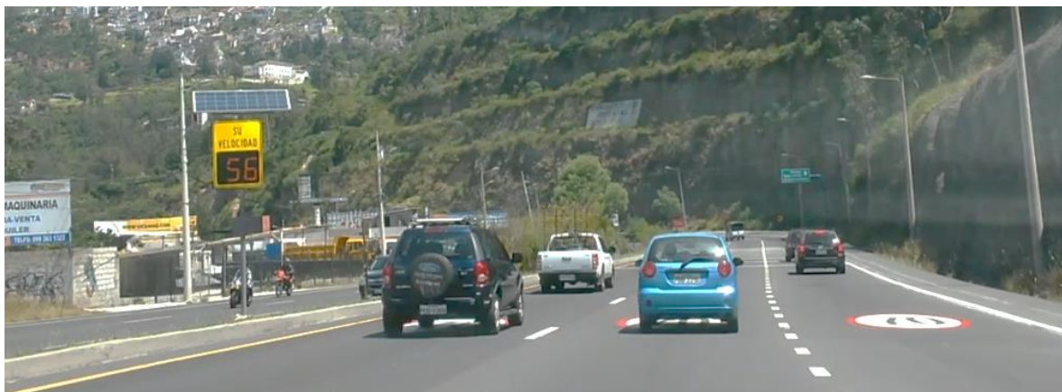
Foto 6-5 Radar de control de velocidad ubicado en la Av. Simón Bolívar
