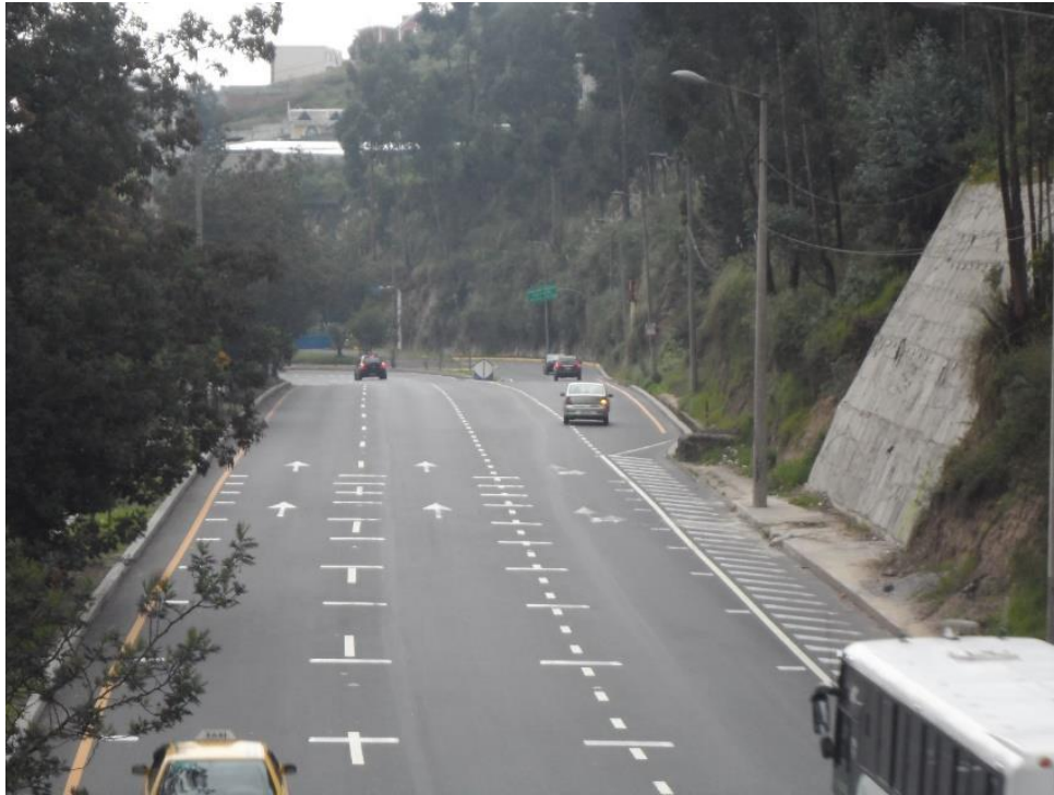
Foto 6-3 Falta de señalización informativa N-S sector Autopista General Rumiñahui
