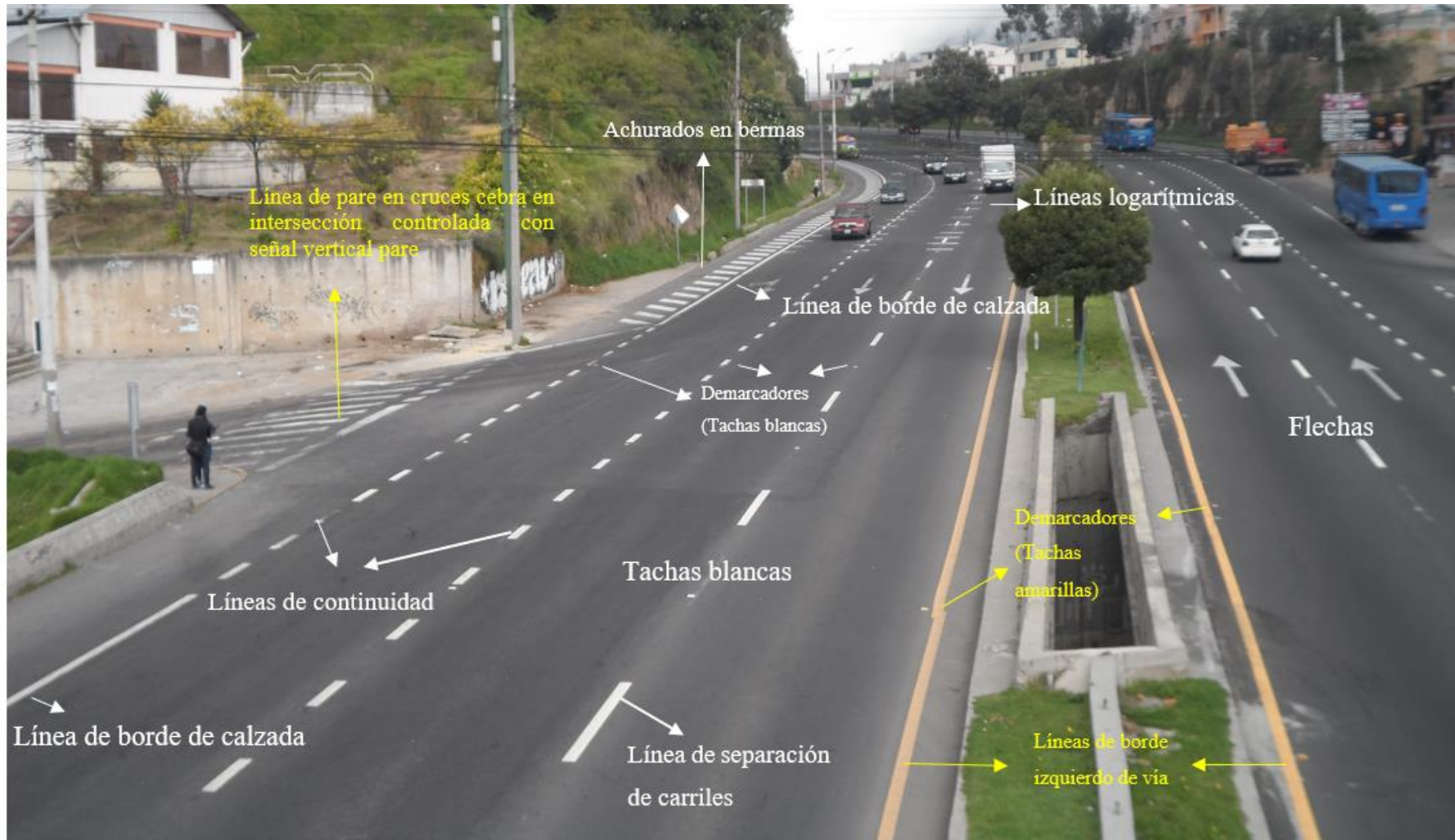
Foto 4-2 Tipos de señalización horizontal Av. Simón Bolívar
