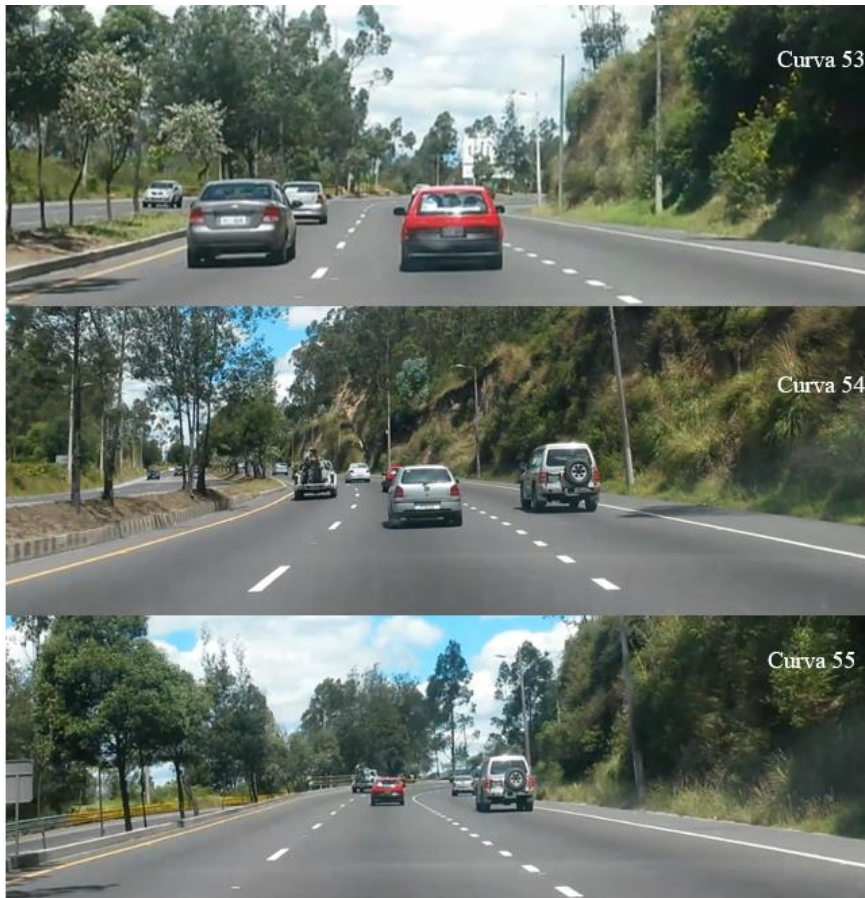
Foto 4-8 Falta de señalización curvas Sector Universidad Internacional N-S
