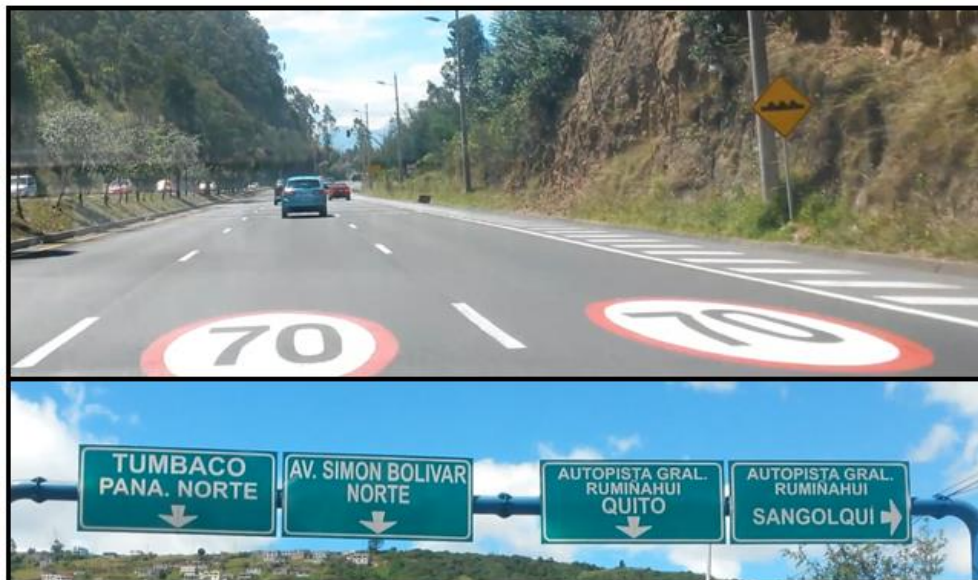
Foto 4-3 Ejemplos de señalización con buen estado de conservación en la Av. Simón Bolívar.
