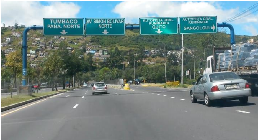
Foto 4-19 Señales de información Av. Simón Bolívar sector Autopista General Rumiñahui sentido S-N.
