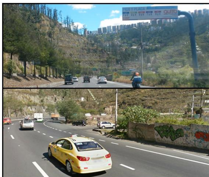
Foto 4-17 Señalización vertical entre Av. Simón Bolívar y Av. De los Conquistadores S-N
