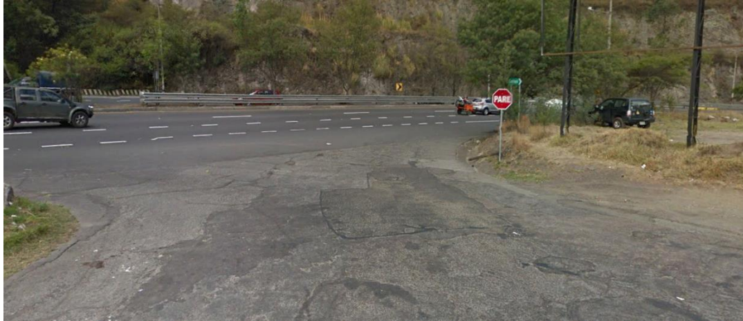
Foto 4-25 Intersección N-S Av. De los Conquistadores con Av. Simón Bolívar en curva 29
