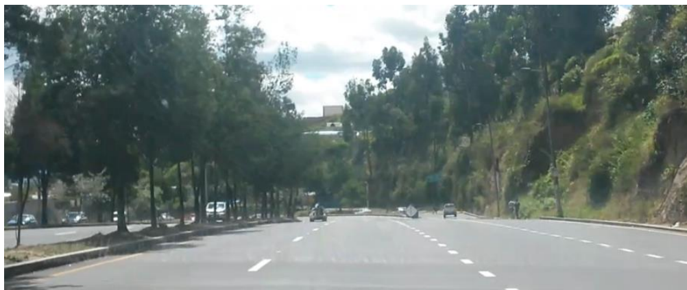
Foto 4-18 Señalización Av. Simón Bolívar sector Autopista General Rumiñahui sentido N-S
