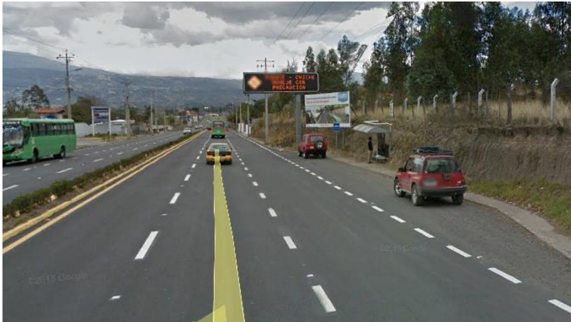
Foto 6-4 Ejemplo de señalización sector Vía Colectora Quito-Pifo (E28C)
