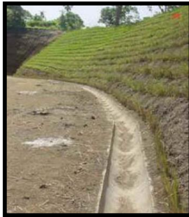
Figura 39. Contracuneta en base de un talud. Fuente: (Alberti, Canales, & Sandoval, 2006)
