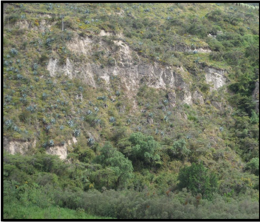
Foto de deslizamiento #9 Vía la Merced
