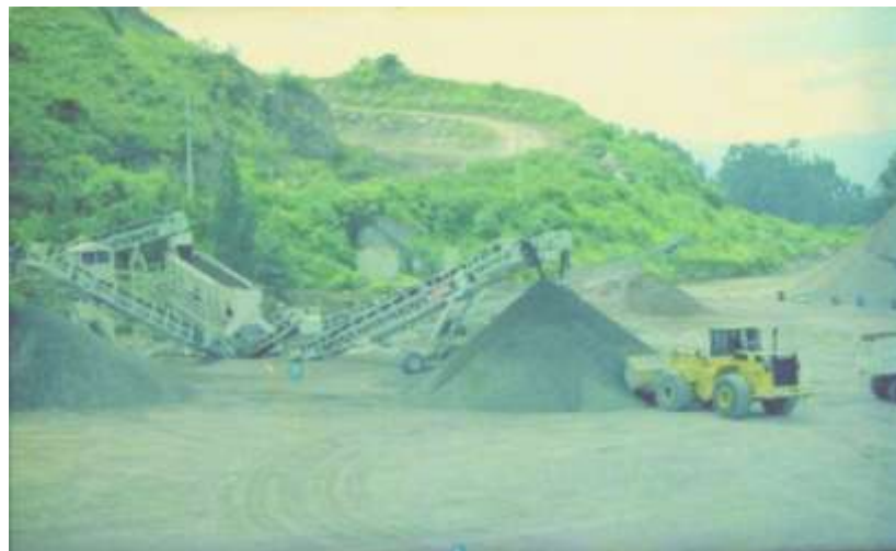
Foto 2.6 Vista parcial de las instalaciones en mina de Agregados Rocafuerte
