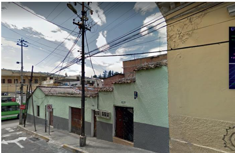
Ilustración 93. Postes en mitad de acera, calle Sincholagua Fuente: (Google Maps, 2023)
