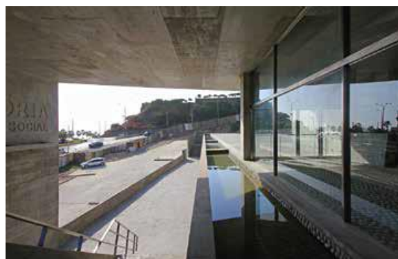
Ilustración 123. Fachada Frontal "LUM"
