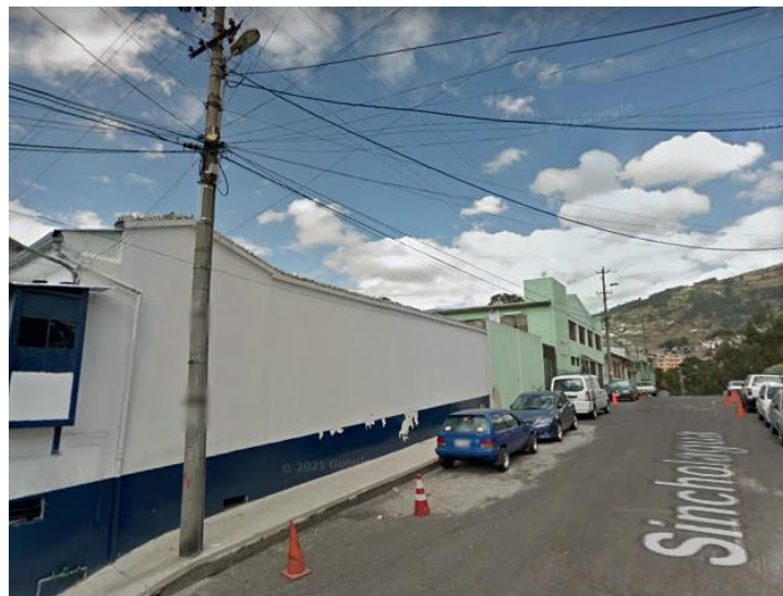
Ilustración 94. Postes en mitad de acera, calle Sincholagua Fuente: (Google Maps, 2023)
