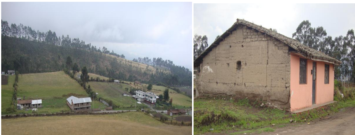
Fotografía 16. Tipos de viviendas en el Sector Rural de Tabacundo
