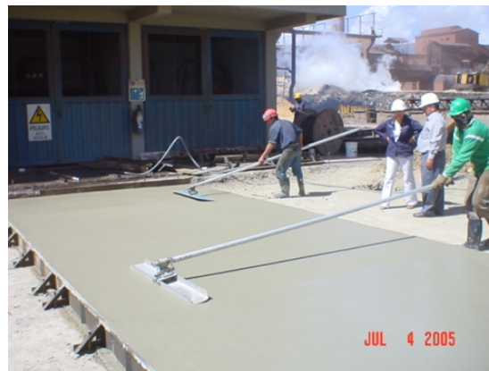
Fig. 4.3. FOTOGRAFIAS FUNDICION PAVIMENTO RIGIDO
