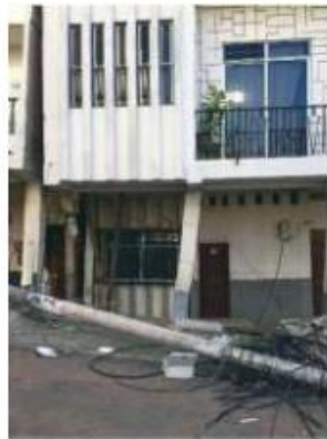
Figura II-8: Columna corta en terreno inclinado (pag.27).(NEC-15, 2015)
