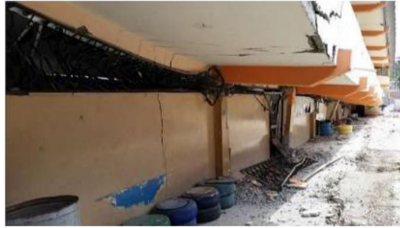
Figura II-7: Columna parcialmente confinada por muros de mampostería (pag 28).(NEC-15, 2015)
