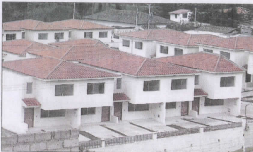
Conjunto Habitacional Balcones del Río se edifica con 46 casas de dos plantas, junto a la empresa Plasticahuo en la avenida Indoamérica.
