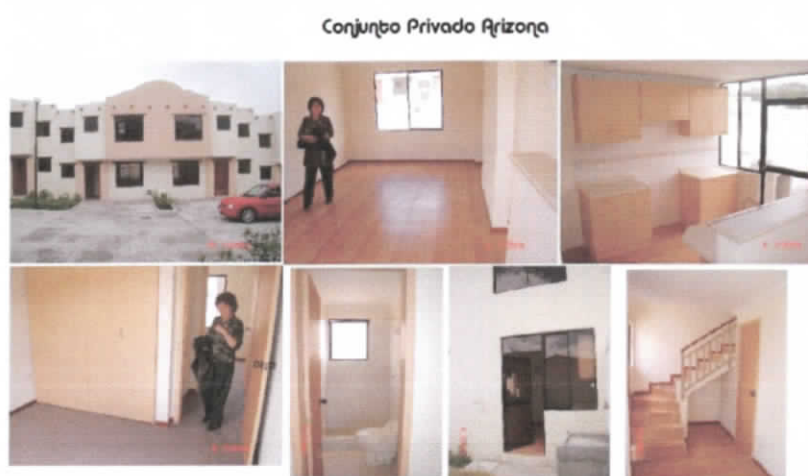
Fig. 1 Conjunto Habitacional Arizona www.aservin.com.ec
