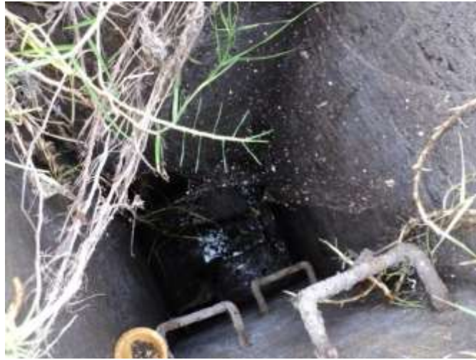
Estado actual de los Pozos de revisión del alcantarillado existente Parroquia Mulaló
