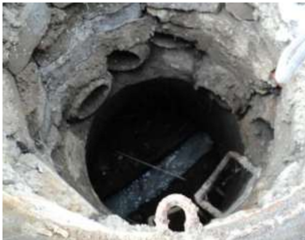
Estado actual de los pozos de revisión del alcantarillado existente Parroquia Mulaló
