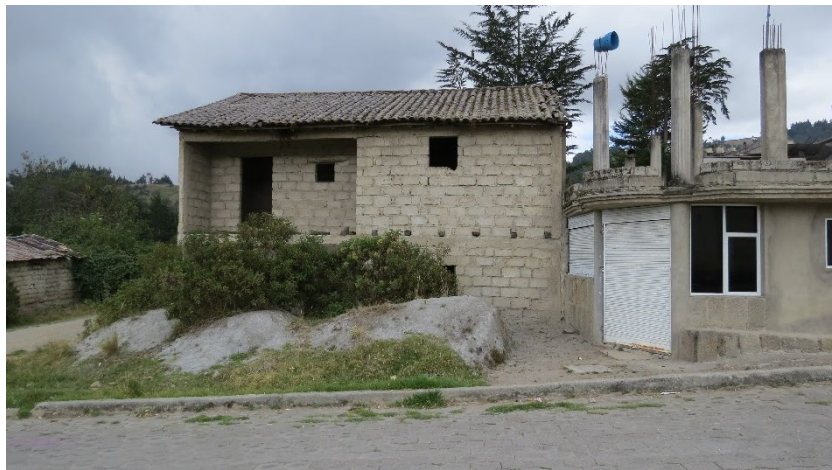
Figura 40 Preexistencias de los lotes este. Soria, 2024
