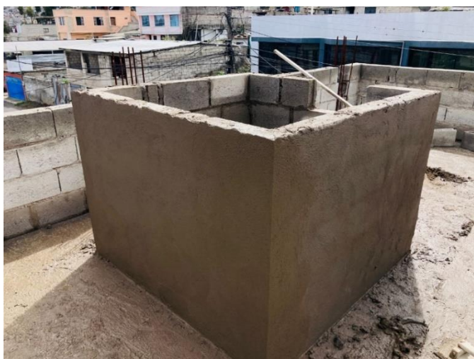
Enlucido de paredes
