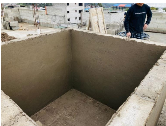
Enlucido de paredes
