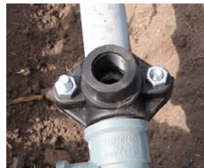
Gráfico No. 44 Collarín instalado en la tubería
