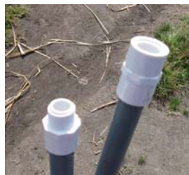
Gráfico No. 45 adaptadores macho y hembra colocados en los tubos
