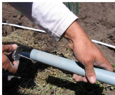
Gráfico No. 40 utilización del pegamento PVC en los tubos
