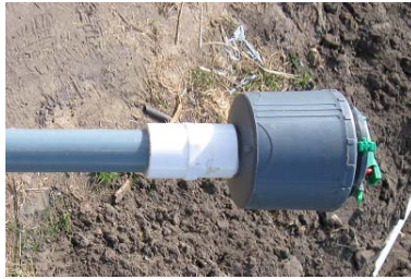
Gráfico No. 46 aspersor colocado en el tubo
