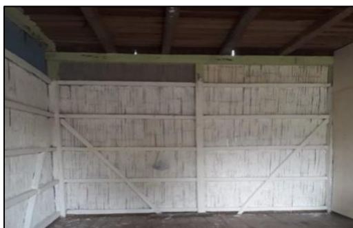
Imagen 9: Colocación de planchas de pleibo dentro del Infocentro (2020).
