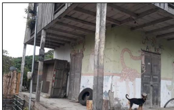
Imagen 10: Fachada del Infocentro antes de su remodelación en julio de 2021.
