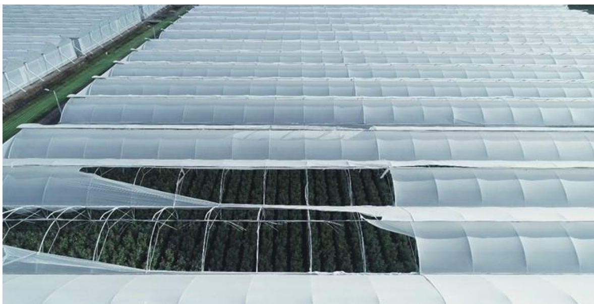
Anexo 05. Daño en la cubierta plástica de los invernaderos en la finca Florycampo vista desde el UAV, Grupo Esmeralda Farms, Ecuador.
