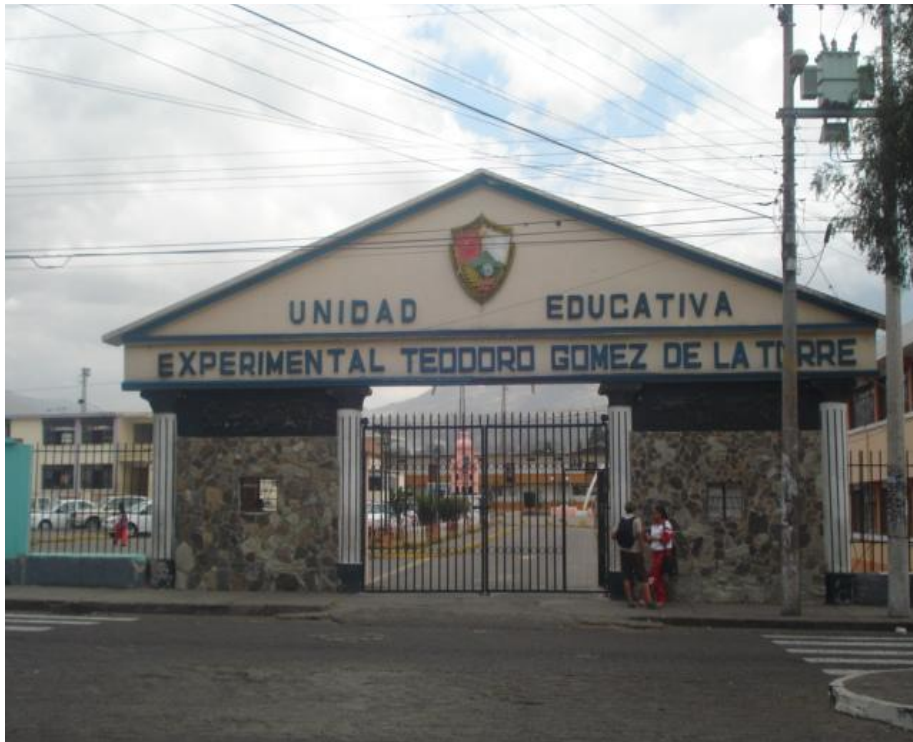
ENTRADA DE LA UNIDAD EDUCATIVA TEODORO GOMEZ DE LA TORRE DE LA CIUDAD DE IBARRA
